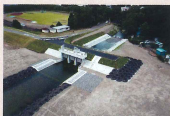
排水樋門工事 東京都立川市
