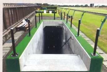
府中競馬場 階段の土木工事
